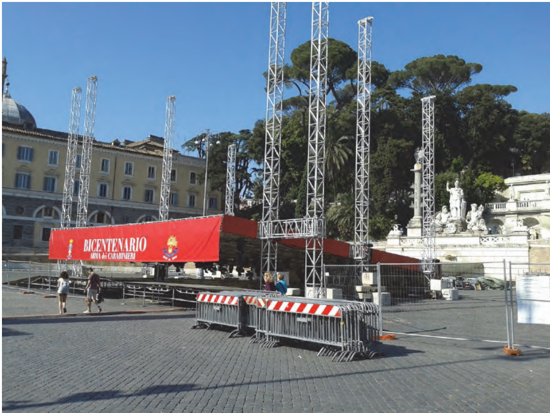
Figura 1.4 – 11 Esempio di copertura realizzata in opera, generalmente a terra e portata in quota con sistemi di sollevamento manuali o motorizzati
