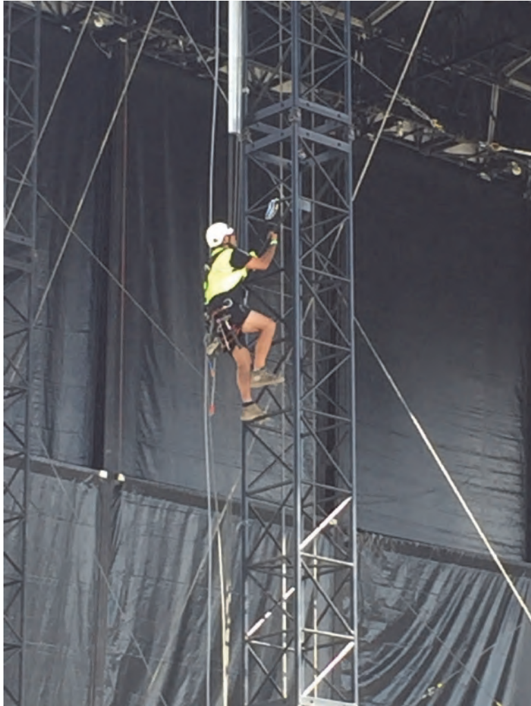
Figura 1.10 – 1 Verifica mediante salita con doppio cordino
