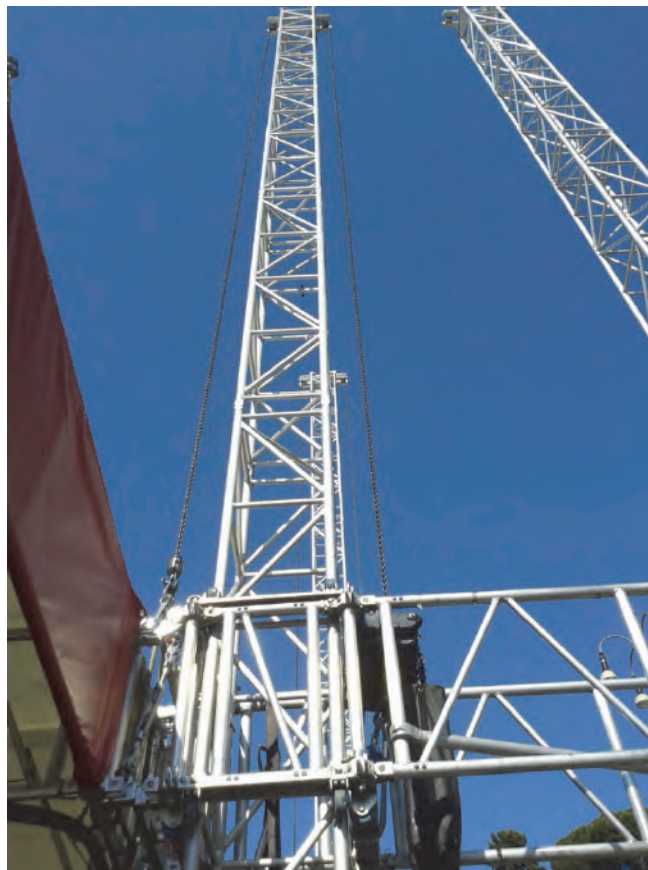
Figura 1.3 – 3 Esempio di sistema di sollevamento della copertura
