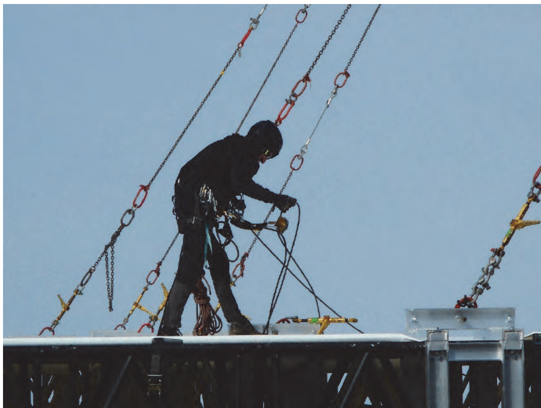
Figura 2.A1 –1 Rigger sulla copertura di un palco – Progressione su fune (Gentile concessione Luca Guidolin)
