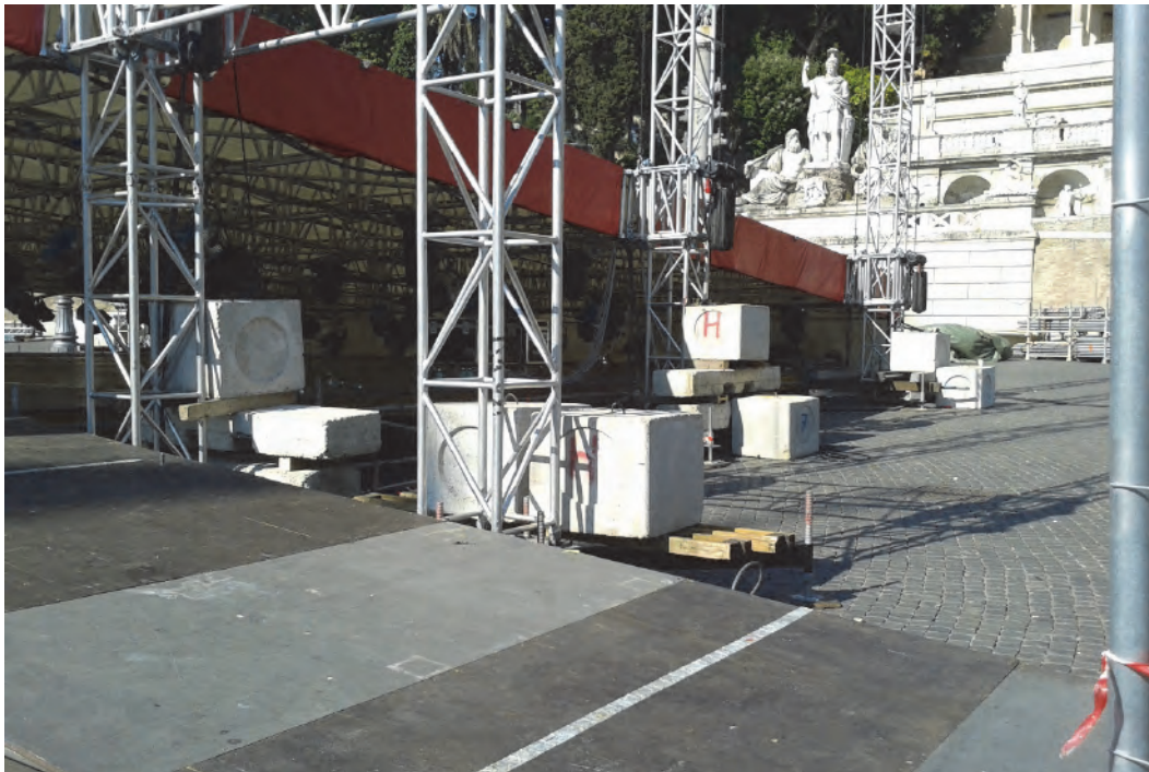
Figura 1.4 – 13 Esempio di posizionamento della zavorra
