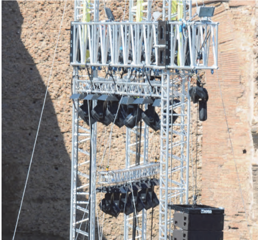
Figura 1.3 – 9 Impianto luci, particolare
