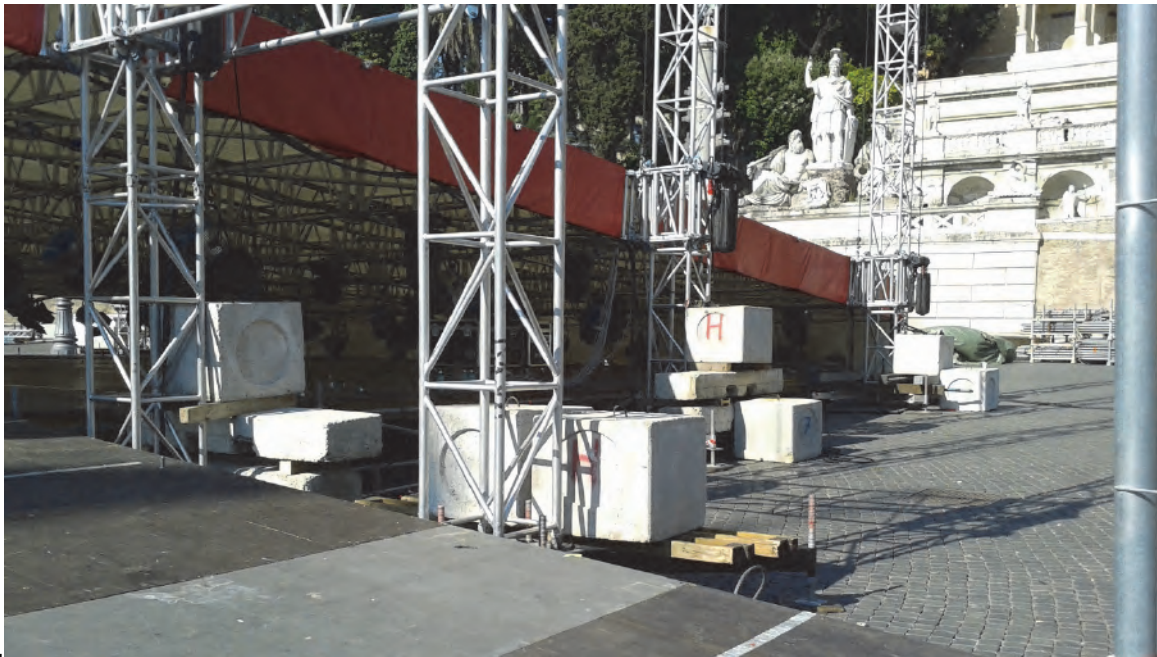
Figura 1.3 – 4 Esempio di posizionamento della zavorra
