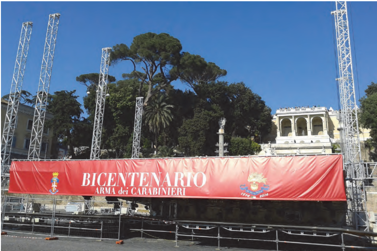
Figura 1.3 – 2 Esempio di palco (pedana, strutture verticali e struttura di copertura) realizzato con sistemi integrati con copertura assemblata a terra
