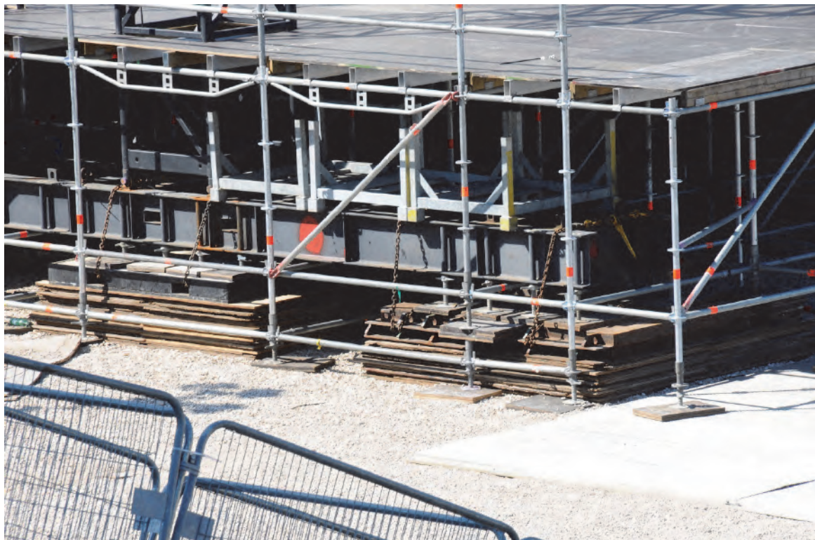
Figura 1.3 – 5 Esempio di livellamento
