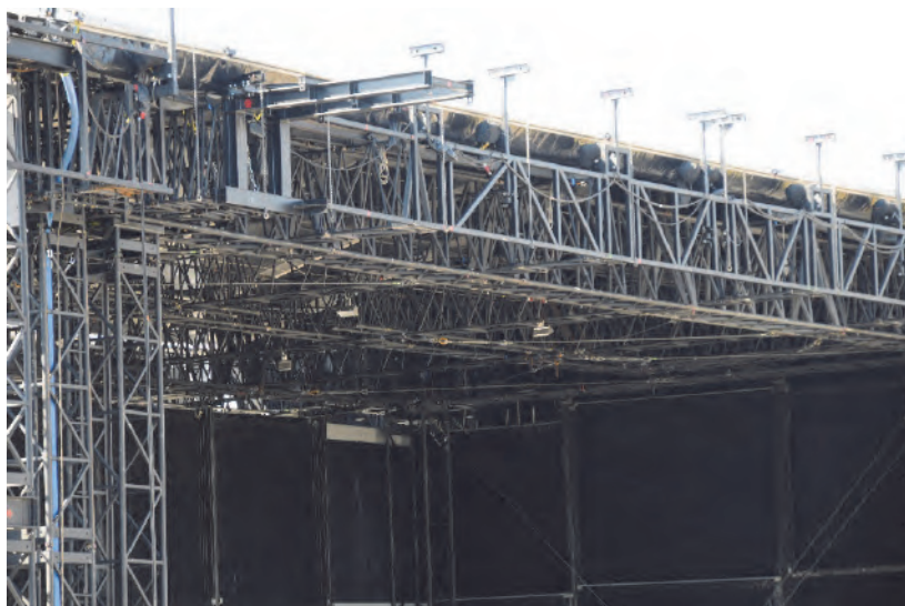
Figura 1.4 – 8 Esempio di palco realizzato con sistemi integrati - Particolare
