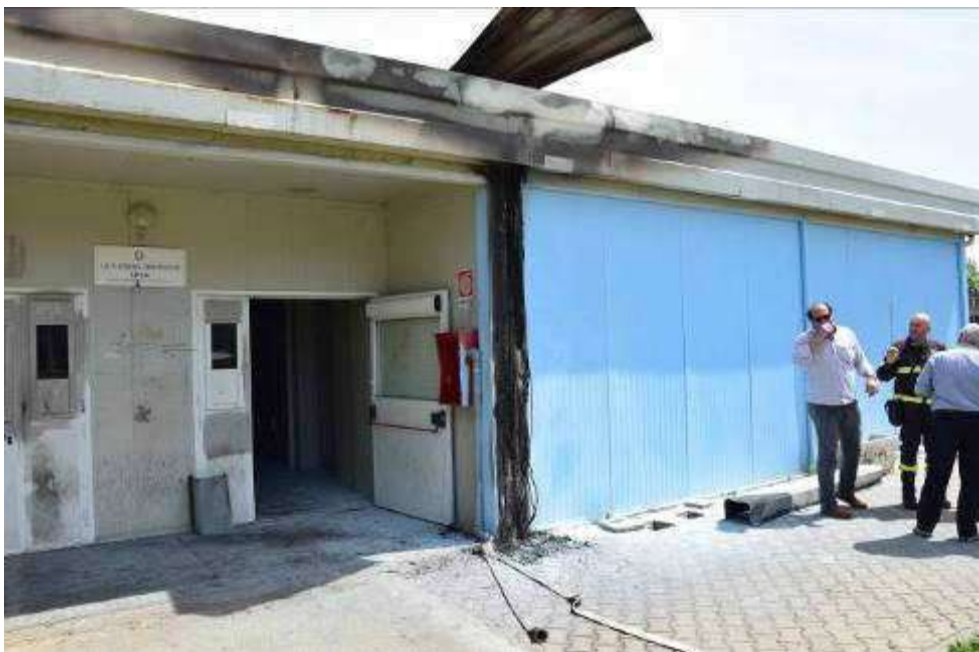
Tratto verticale del passaggio dei cavi elettrici
