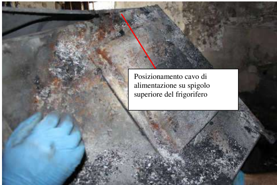
Cavo elettrico di alimentazione del frigorifero
